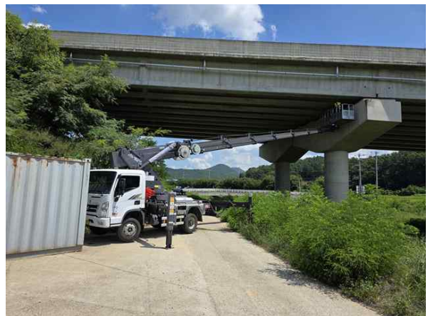
고소점검차를 이용한 근접조사
