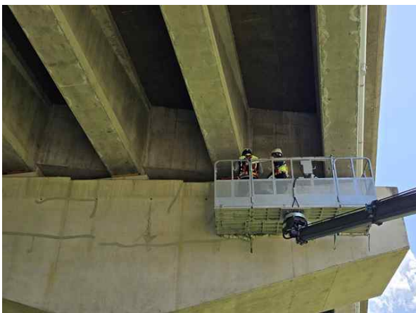
고소점검차를 이용한 근접조사
