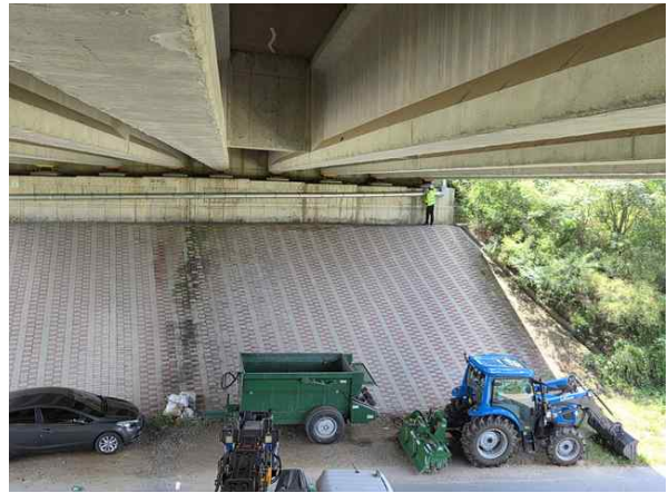
교대 A2 기초 전경
