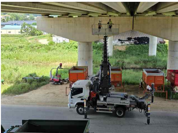
고소점검차를 이용한 근접조사
