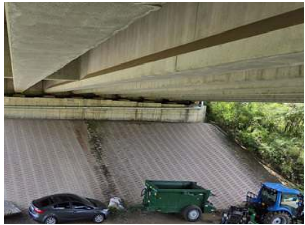
교대 A2 기초 전경
