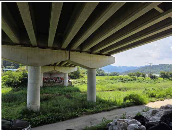
교각 P1 기초 전경
