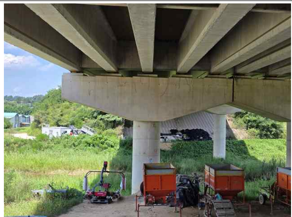
교각 P2 기초 전경
