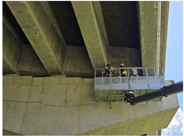
고소차를 이용한 부재치수 현장측정
