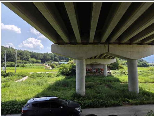
교각 P1 기초 전경
