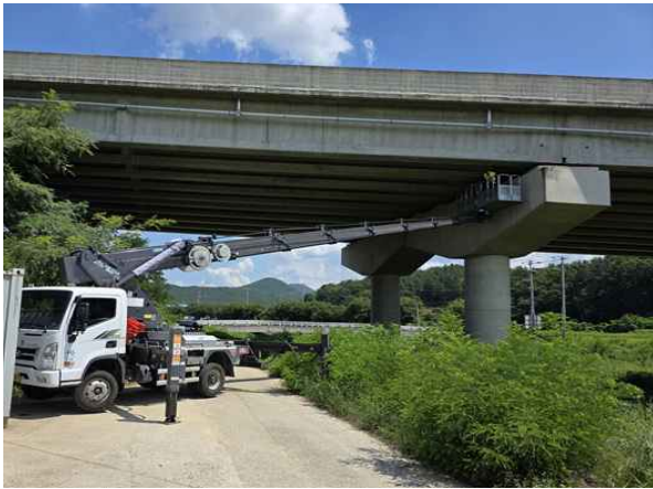
고소차를 이용한 부재치수 현장측정
